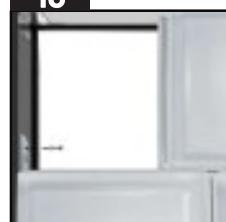
Se prescindirá de la separación vertical ARS-H19. Aplicar una cantidad reducida de silicona ReadySil tanto en la última separación vertical como en el perfil horizontal. No aplicar silicona ni en la superficie superior del último bloque ni en el lateral del mismo donde aún no se había colocado la separación vertical.
