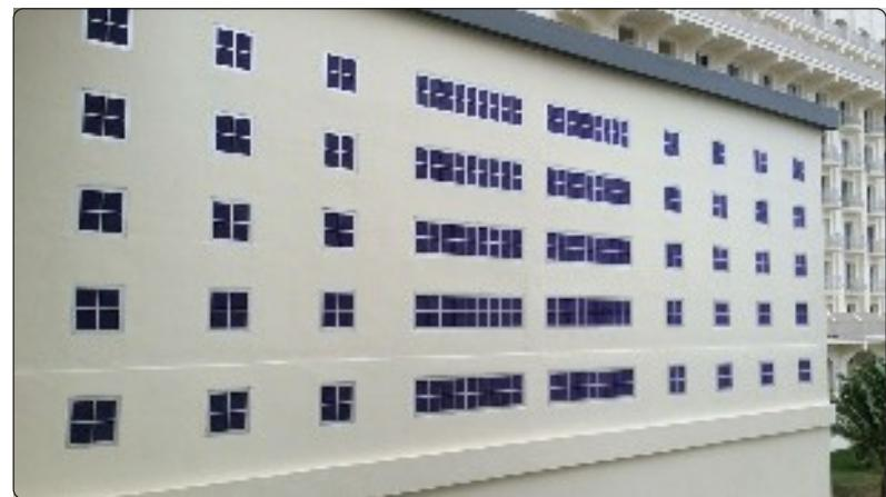
SISTEMA MODULAR DE ALUMINIO PARA LADRILLO DE VIDRIO. VÁLIDO PARA PAREDES DE GRANDES Y PEQUEÑAS DIMENSIONES. UTILIZABLE EN EXTERIORES E INTERIORES.
