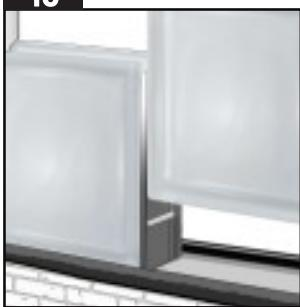
Repita los pasos 5, 6, 7 y 8 hasta que haya instalado el penúltimo bloque de la fila. Comprobar frecuentemente la correcta alineación de las juntas verticales. Atornillar los enchange ARS-E01.
