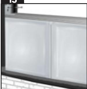
Posicionar el perfil horizontal y fijarlo a los dos extremos con los enganches ARS-E01. Aplicar la silicona ReadySil en las tres superficies que estarán en contacto con los bloques de toda la última fila menos el último bloque de un extremo (ver foto 6A).
